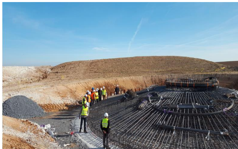
Photo 4 : Construction d'une fondation Source : Boralex
