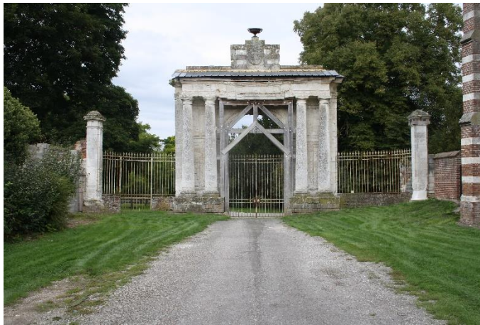
Photo 26 : Porte d'entrée du château d'Oissy Source : ALISE Environnement
