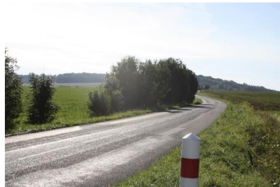
Photo 21 : Route départementale D38
