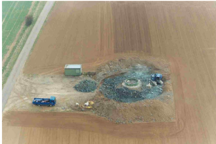
Photo 29 : Exemple de démontage de la plateforme et des fondations d'une éolienne
