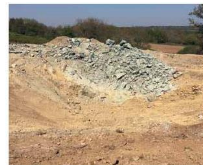
Photo 8 : Retrait de l'intégralité du béton Source : Boralex
