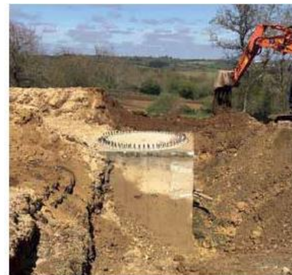
Photo 6 : Excavation des fondations Source : Boralex
