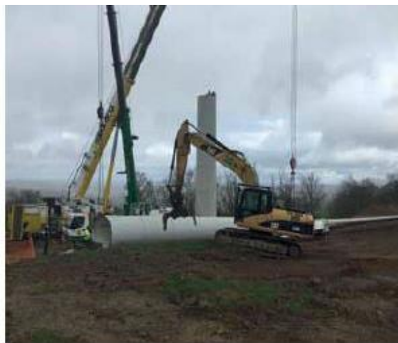
Photo 5 : Démontage d'un mat d'éolienne Source : Boralex
