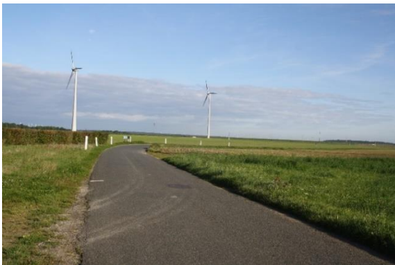
Photo 20 : Route départementale D141
