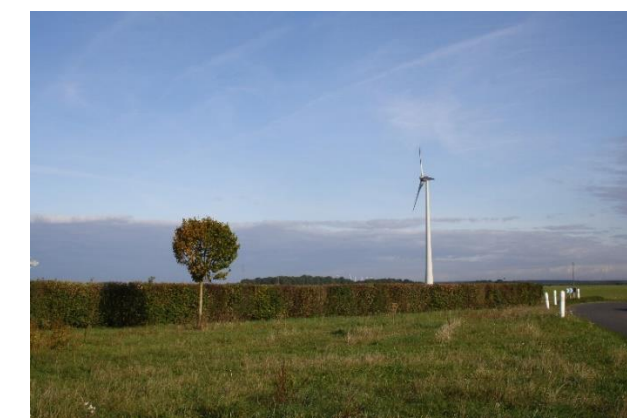
Photo 14 : Eolienne ENERTRAG à proximité de la zone d'étude
