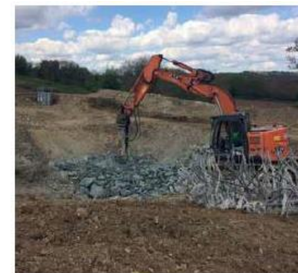
Photo 7 : Démolition de la fondation Source : Boralex
